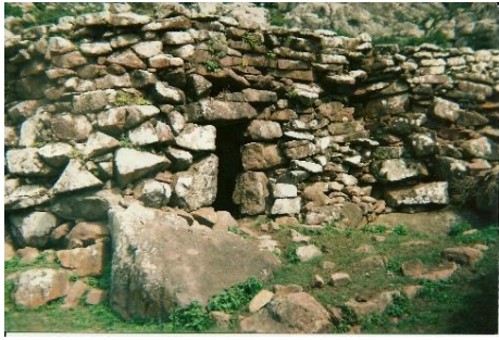
صورة لمدخل مبنى في منطقة مرها
